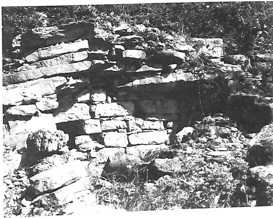
“Cavaneo” della Rocchetta, a pianta quadrata, allo stato di rudere. Si nota, alla sommità del muro, il notevole spessore dei corsi aggettanti della pseudovolta.
