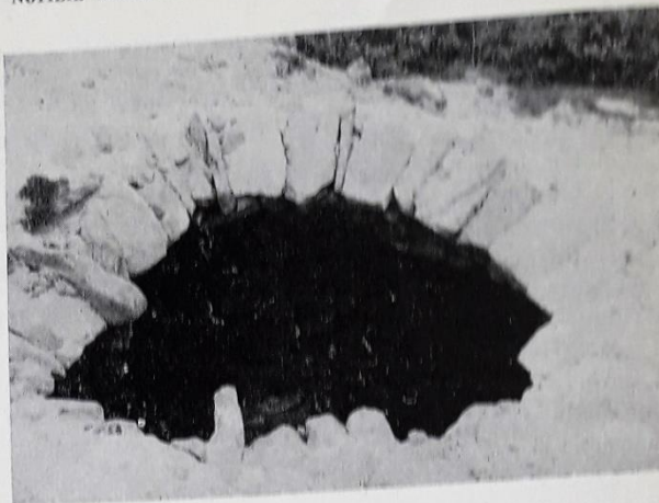
Fig. 1 - Ghiacciaia delle « Fosse ». Fotografia fatta dall'alto. La parte superiore della cupola è crollata lasciando chiaramente visibile una sua sezione orizzontale. Le pietre appaiono aggettanti e inclinate all'interno, disposte a cuneo e forzate come tante armille di un arco.
