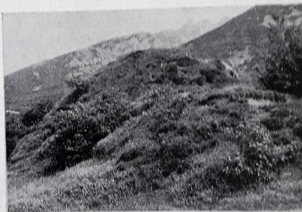
Fig. 2 - Ghiacciaia delle « Fosse ». Aspetto esterno. Dai due lati, grosso modo orientati verso levante e ponente, sono stati apposti due terrapieni (uno, quello di ponente, è la montagnola che si scorge in primo piano a destra) di significato non ben definibile. Forse una maggiore protezione contro il sole.
