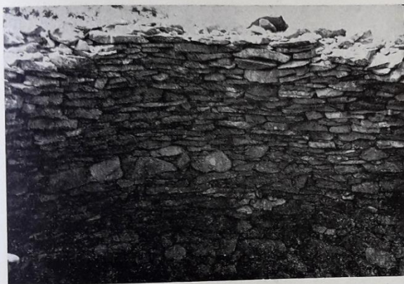
Fig. 4 - Ghiacciaia del Padule. Un aspetto della pseudo-volta vista dall'interno.
