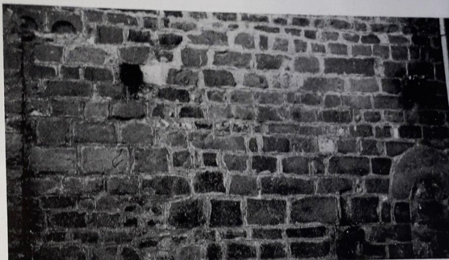
Fig. 1 - Chiesa parrocchiale di Casola. Particolare di paramento murario di età romanica
